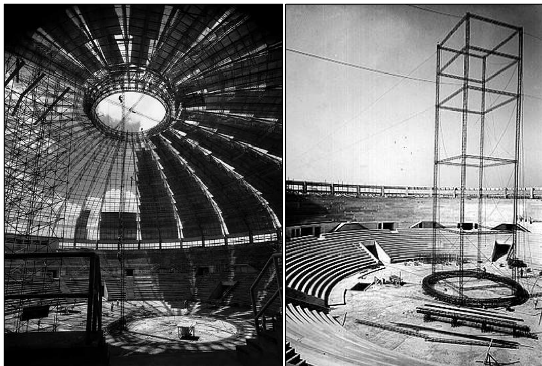
Figura 3: Construção do Ginásio do Ibirapuera
