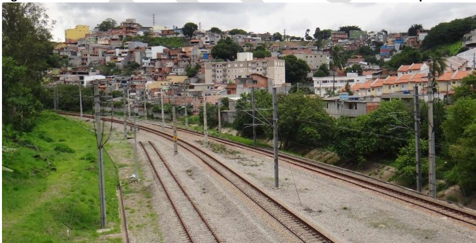
Figura 116: Postejamento com elementos de concreto alimentando vias independentemente
