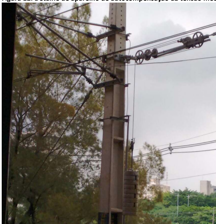
Figura 12: Detalhe de aparelho de autocompensação da tensão mecânica nos fios de contato e messageiro
