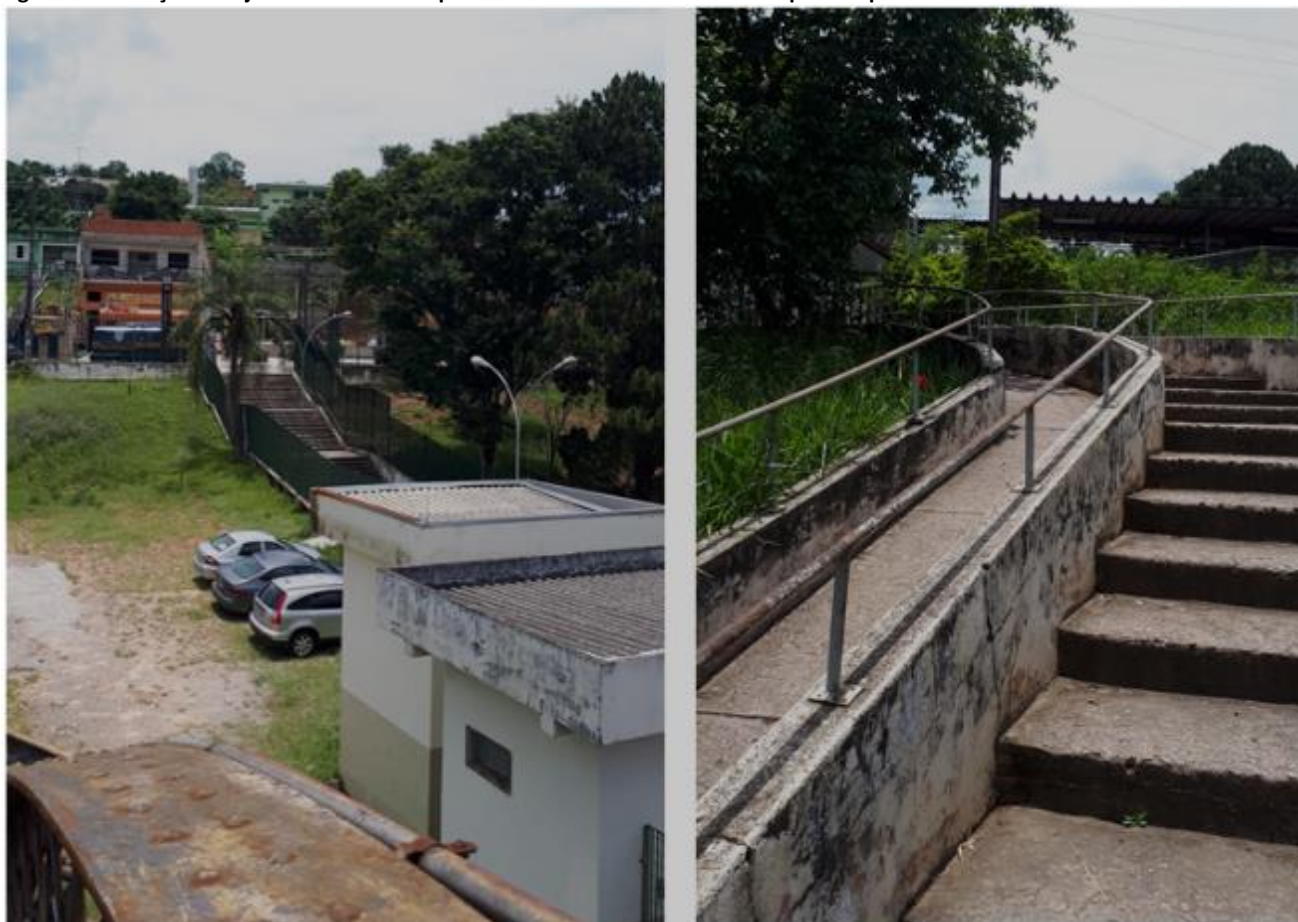
Figura 111: Estação Botujuru: Escadas e rampa acentuada a serem substituídas por rampas acessíveis
