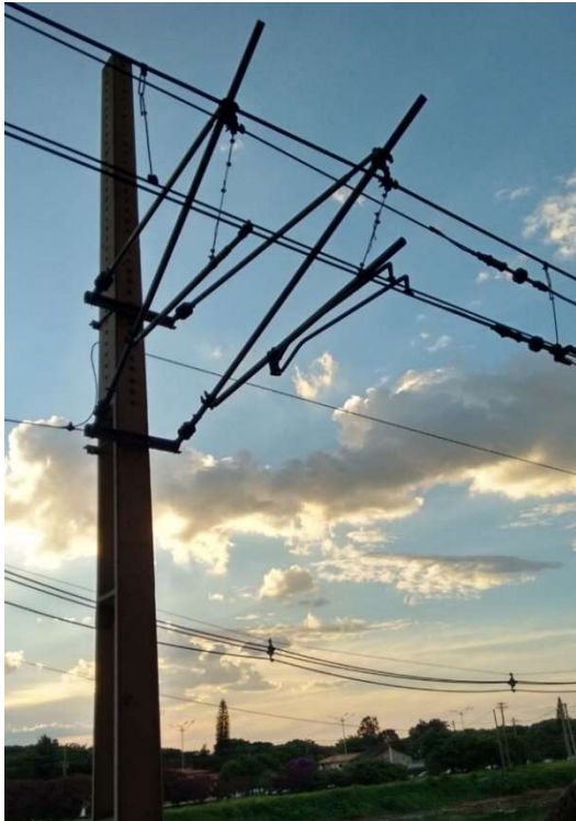
Figura 137: Detalhe de montagem que permite a separação física das catenárias para uma delas ser ancorada
