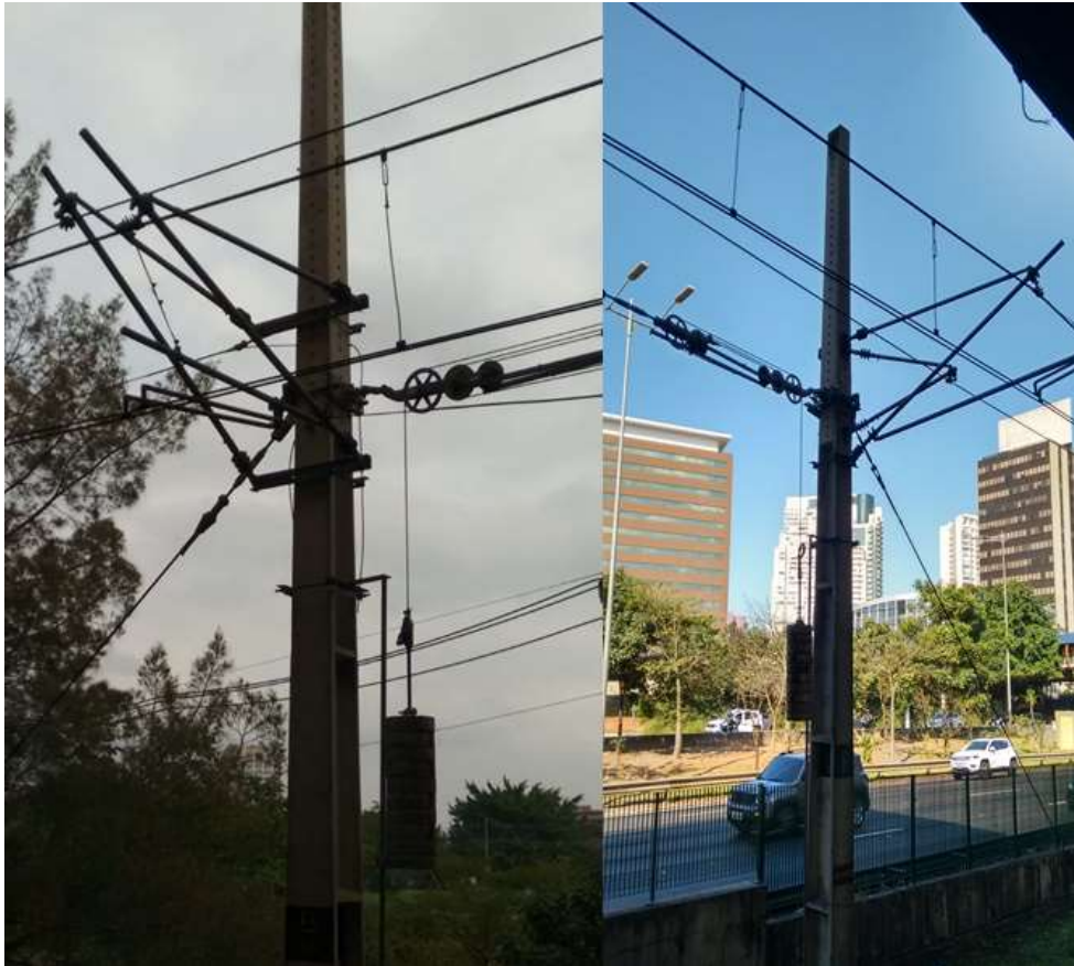
Figura 159: Detalhe de montagem com aparelhos tensores, contrapesos e roldanas
