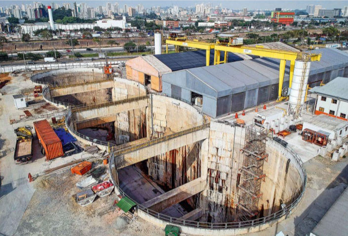
En la foto, sitio de construcción de la Línea 6 Naranja de Metro de São Paulo
